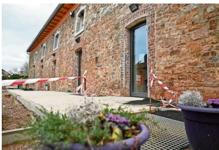
Im Hof des Gutshauses haben die Pflasterarbeiten begonnen.
